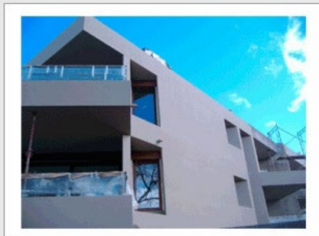
EDIFICIO SOL DEL VALLE - 2010
